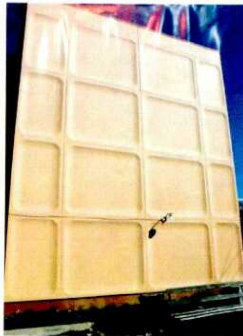
Imagen 55 Fachada lateral ciega (Comisión de Estudios Habitacionales y Urbanos MINVU, 2017) - Registro Consultora URBE - julio 2017
